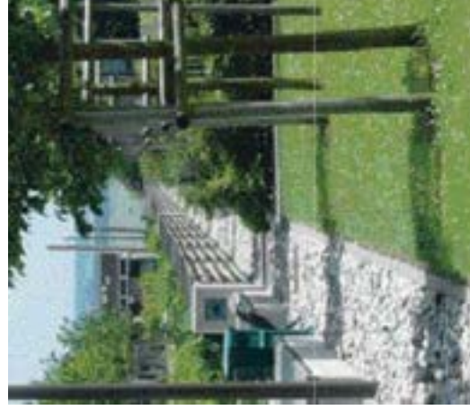
Exemple de tranchée d'infiltration
