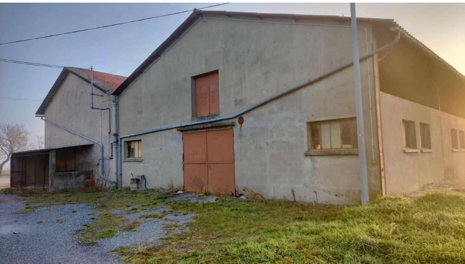
Ferme du Moulas - Bâtiment de stabulation
