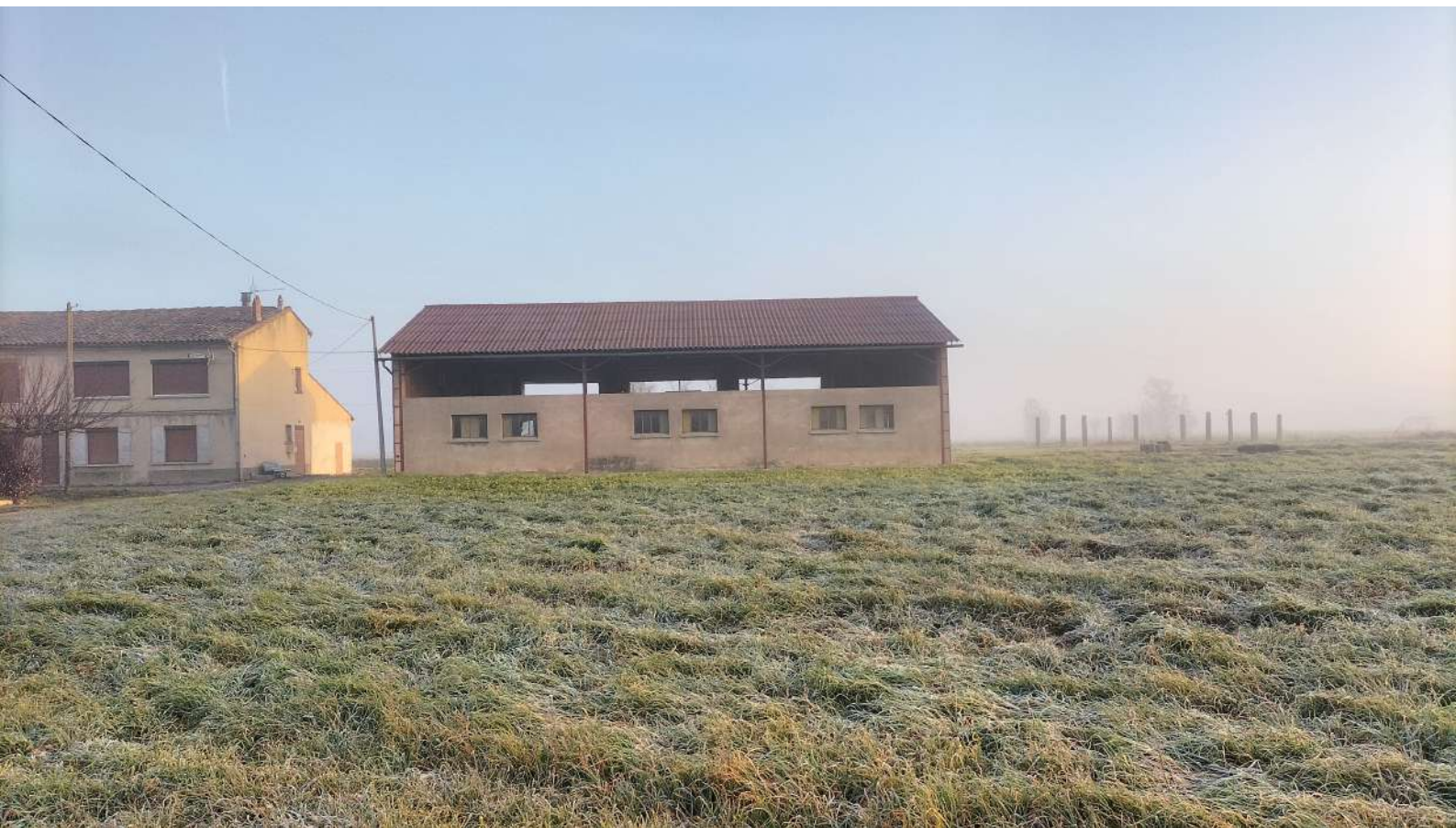
Ferme du Moulas - Bâtiment de stabulation
