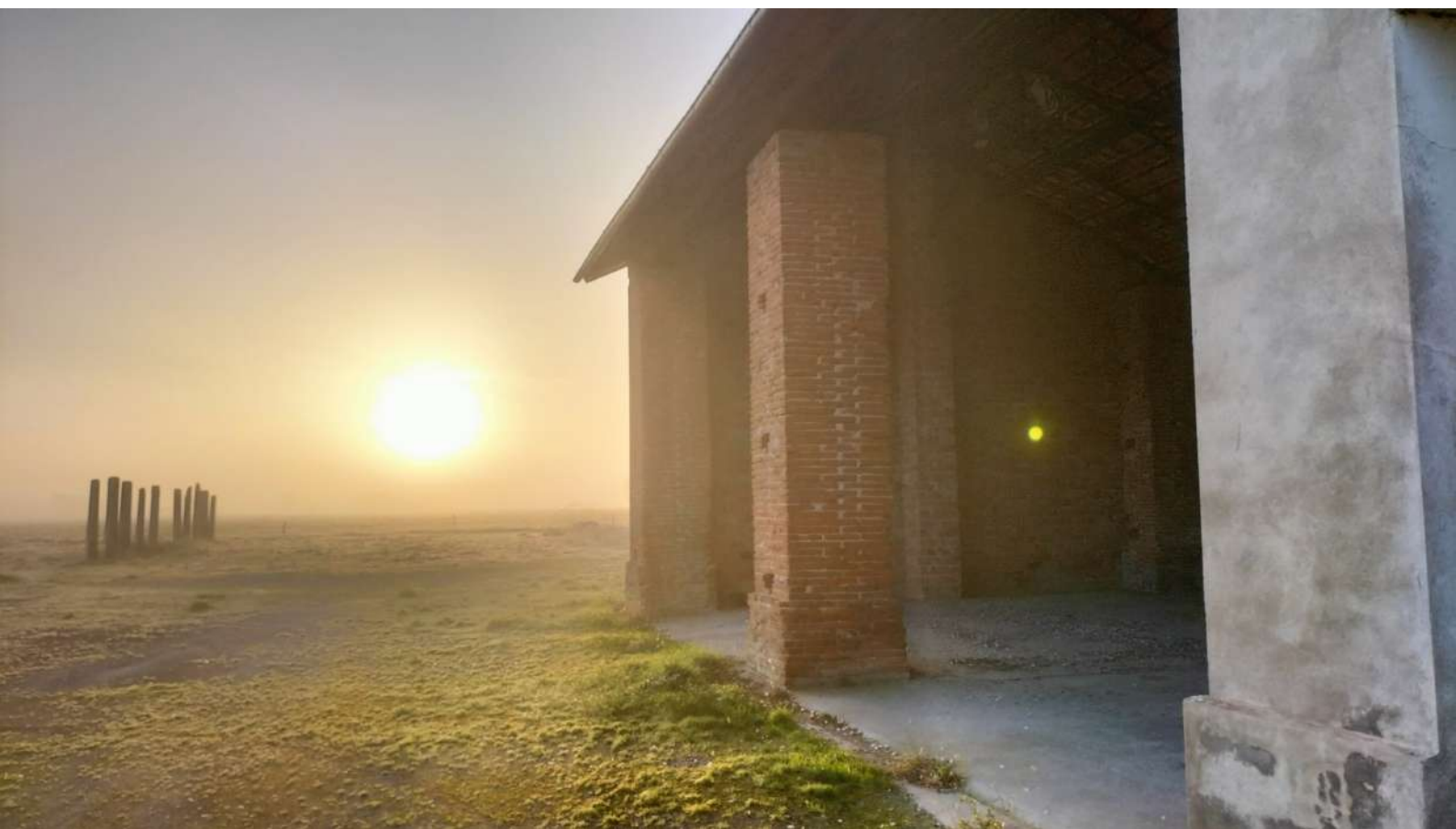
Ferme du Moulas - Bâtiment de stabulation
