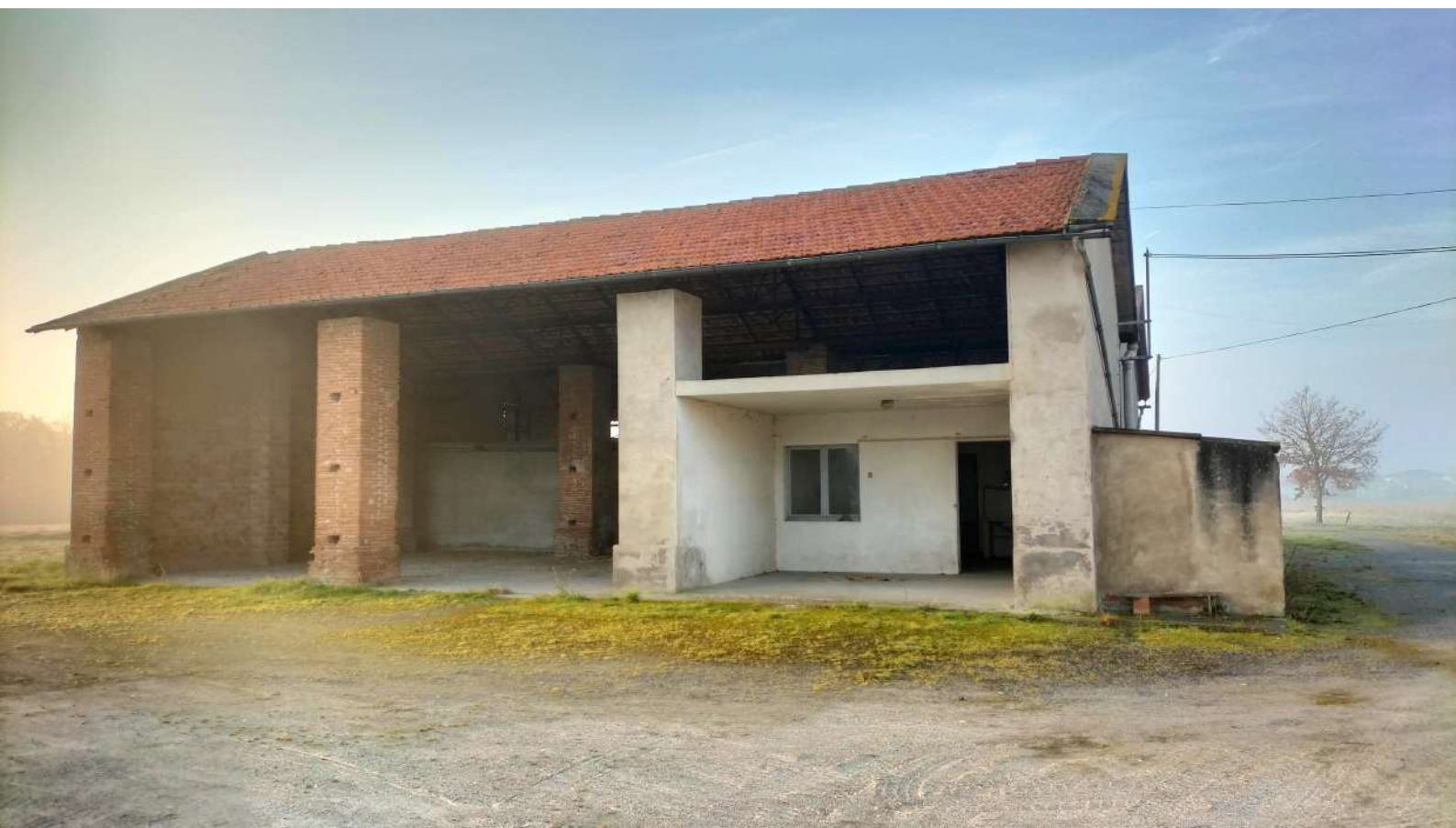
Ferme du Moulas - Bâtiment de stabulation
