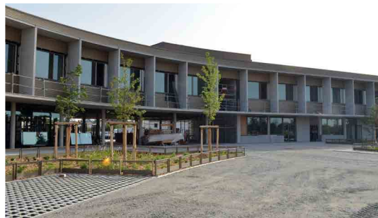
Construction en cours du collège Juin 2022
