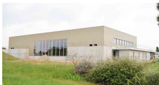
Construction en cours du gymnase Mai 2022
