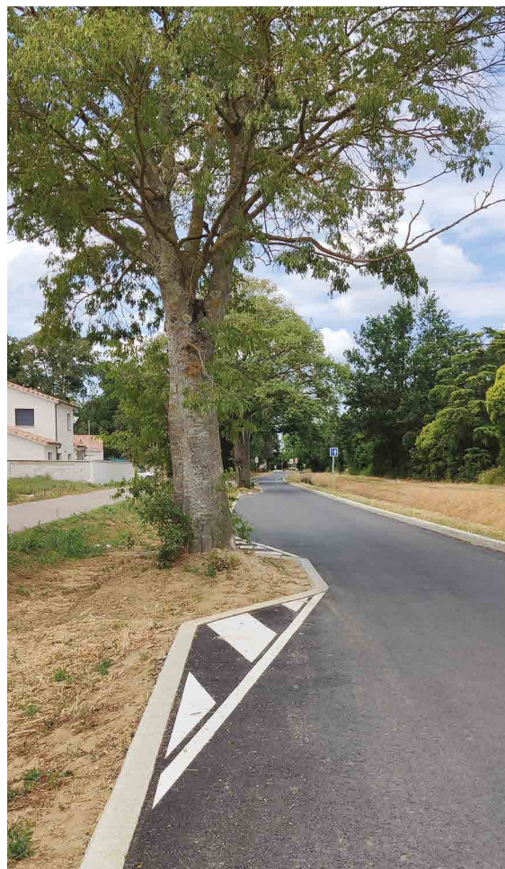
Requalification du chemin du Château d'Eau - Février 2022
