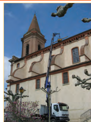
Travaux de remaniement de la charpente et de réparation de la poutre endommagée - Avril 2007
